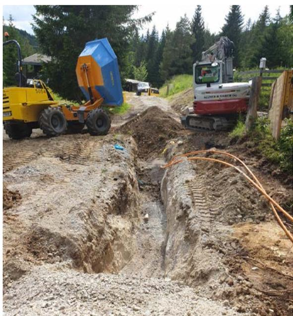
Verlegung der Wasser- und Glasfaserleitungen in der Unterkerle.
