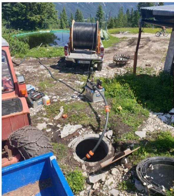
Einblasen eines 2,5 Kilometer langen Glasfaserkabels auf der Rauthütte.
