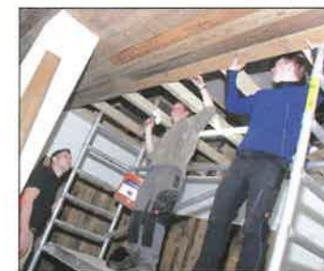
Zeitaufwändige Montage der Deckenkonstruktion aus Altholz
